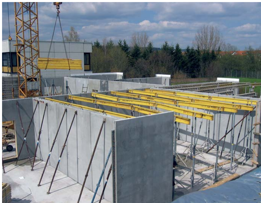
Die Wände des Erweiterungsbaus stehen, bald wird die Decke folgen
