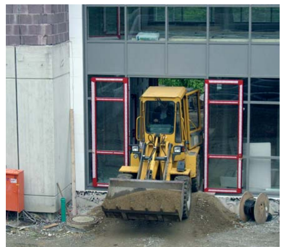
Erdreich, Schotter, Beton und Pflastersteine gelangten nur schaufelweise ...
