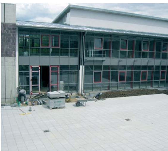
... durch den Eingangsbereich des Gebäudes in den Innenhof
