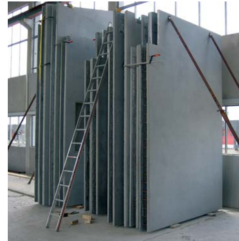
Die Fertigteile wurden stehend gelagert, um Ausblühungen, Verfärbungen und Lagerstellen zu vermeiden
