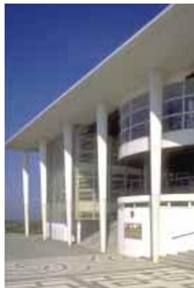
FRANCE LAFARGE CEMENTS Collège de Sausset-Les-Pins (Bouches du Rhône) dont certains éléments architectoniques préfabriqués, colonnes et façades, sont à base de ciment superblanc.
