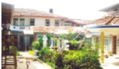
Les sacs de ciment ont été utilisés pour couler le chemin de l'orphelinat et pour construire un mur de séparation entre la route et l'aire de jeux.
